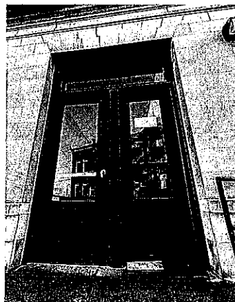
Existing Side Door
